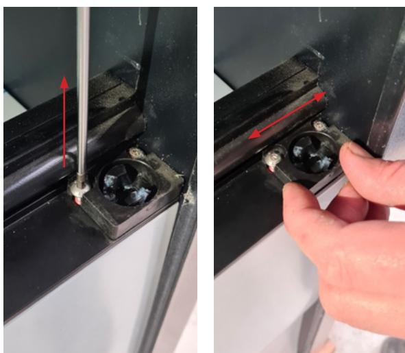
**ITA** Allentare le viti del perno inferiore per poterlo spostare, poi fissare nuovamente le viti
